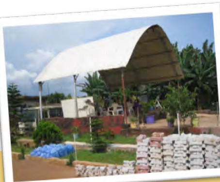
Een nieuw lokaal in aanbouw
