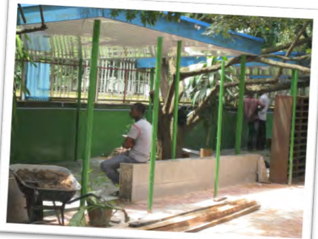
Een nieuw leslokaal in aanbouw
